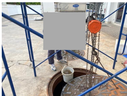
รูปที่ 2-25 ขณะมีการบำรุงรักษาระบบบำบัดน้ำเสีย มีการกั้นพื้นที่และมีการควบคุมการทำงานโดยเจ้าหน้าที่ที่ชำนาญการ
