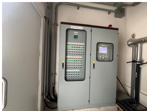
รูปที่ 2-24 ตู้ควบคุมระบบบำบัดน้ำเสีย และมอเตอร์ไฟฟ้า สำหรับระบบบำบัดน้ำเสียโดยเฉพาะ
